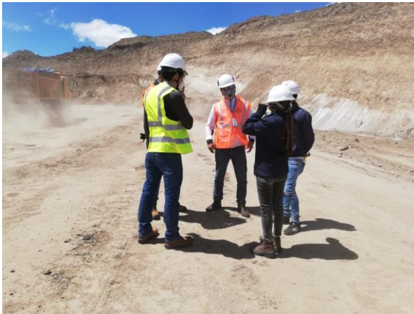
Inicio de Obra desbanque de tierra
