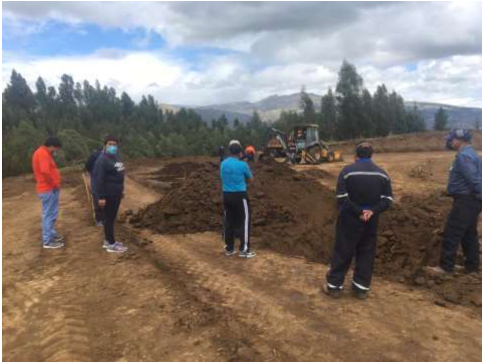
Imagen 8. Construcción Cementerio Municipal
