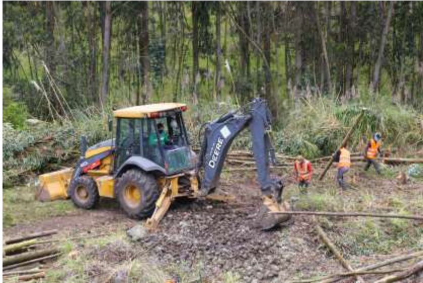
Imagen 12. Construcción Planta de Tratamiento Comunidad La Chimba-Olmedo
