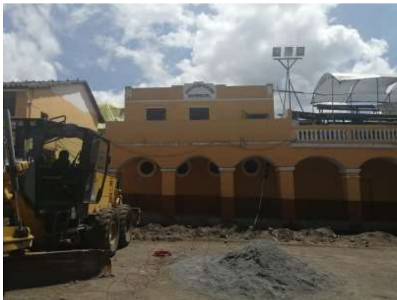
Imagen 11. Trabajos Plaza Dominical
