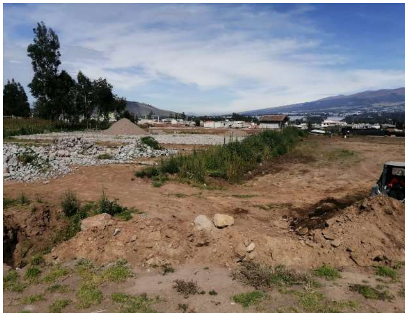
Imagen 19. Trabajos en el polideportivo Parroquia Juan Montalvo
