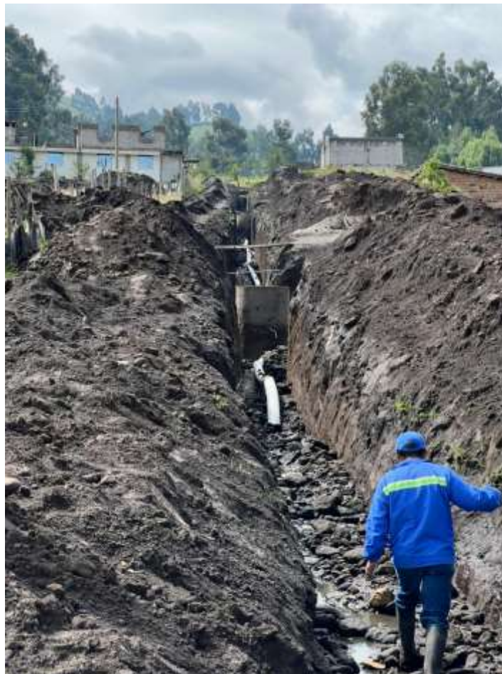
Imagen 13: Alcantarillado Comunidad Convalecencia
